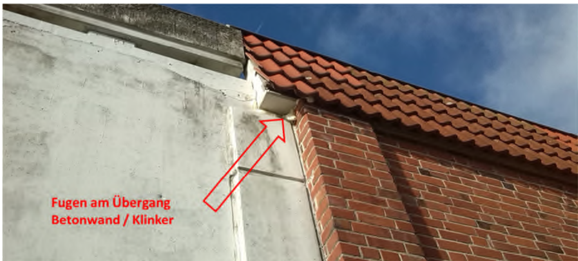
Abb. 1.8 Beispiel 4 für ein potenzielles Spalten- Winterquartier (bereits mit Bauschaum verfüllt) im Außenbereich des Parkhauses.
