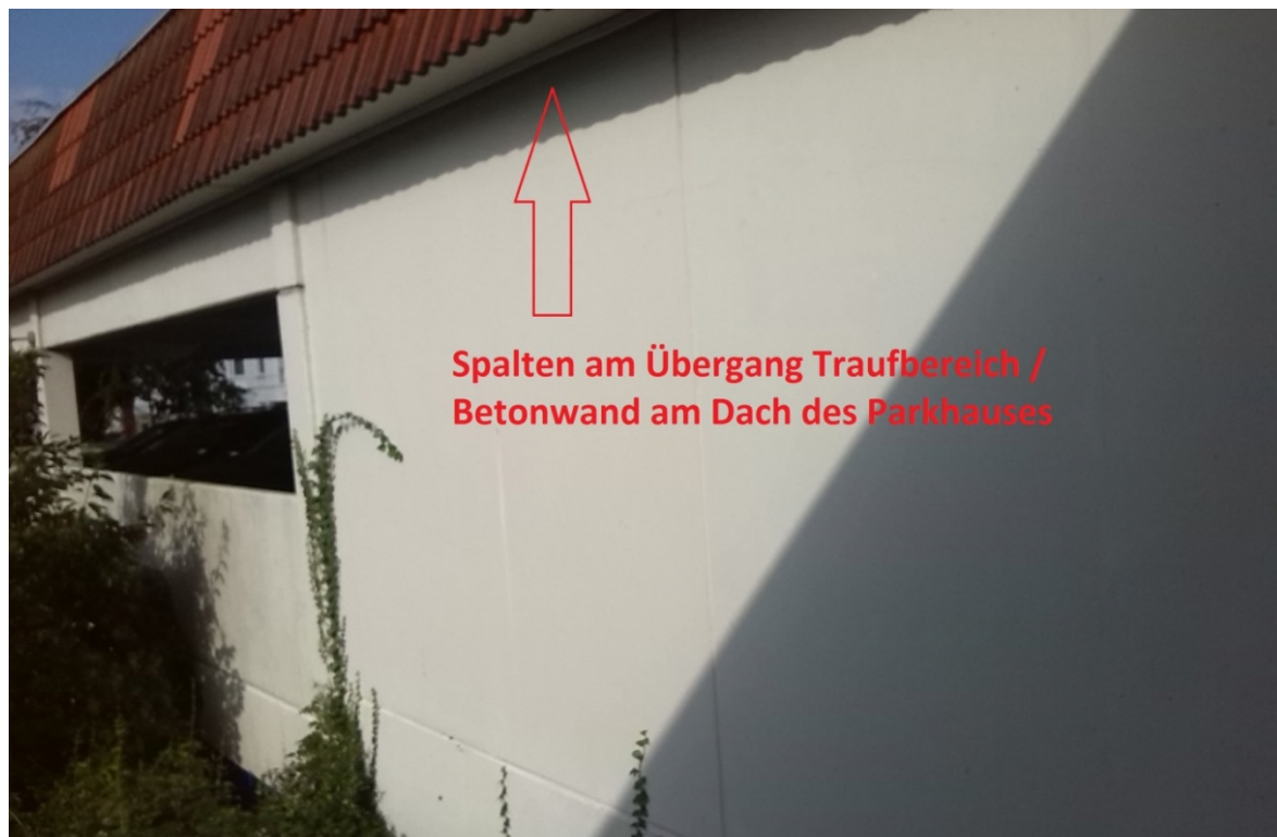
Abb. 1.6 Beispiel 2 für ein potenzielles Spalten- Winterquartier im Außenbereich des Parkhauses.
