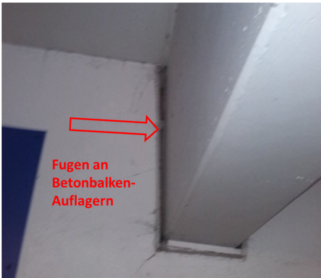
Abb. 1.4 Beispiel 3 für ein potenzielles Spalten- Winterquartier im Inneren des Parkhauses.
