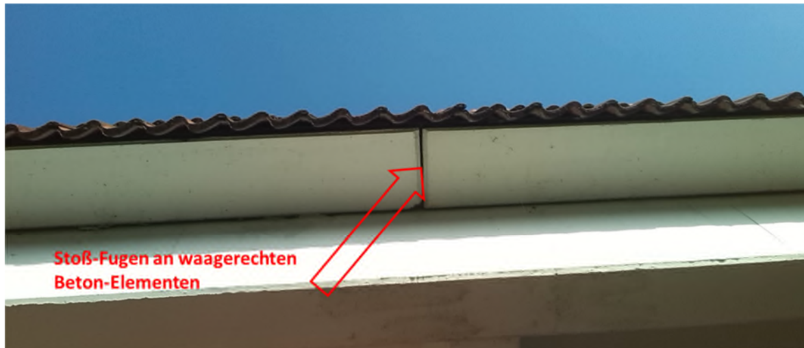
Abb. 1.5 Beispiel 1 für ein potenzielles Spalten- Winterquartier im Außenbereich des Parkhauses.
