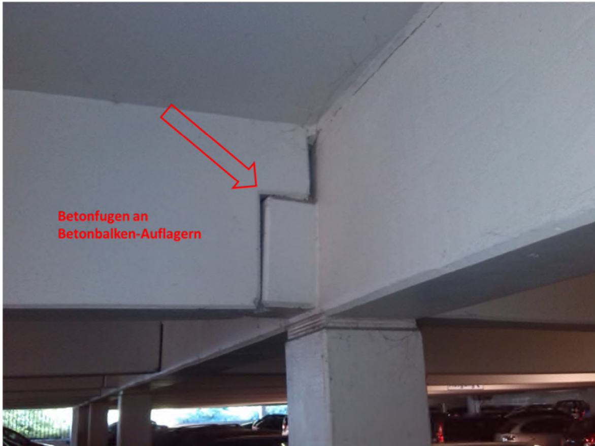
Abb. 1.2 Beispiel 1 für ein potenzielles Spalten- Winterquartier im Inneren des Parkhauses.
