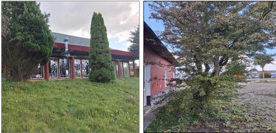
Abb. 2.1 Links: Blick von der Robert-Koch-Str. auf das ehemalige Restaurantgebäude mit davor gepflanzten Gehölzstrukturen und Rasenfläche, Blickrichtung Nordwest. Rechts: Blick auf einen Weißdorn vor der nördlich gelegenen Rückseite des „Bambus Palast“, Blickrichtung West (Fotos: J. Metternich, 23.09.2025).
